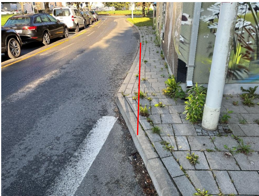
Abb. 2.3: Wunsch des ÖPNV zur Entschärfung der Ecke im Bordverlauf
