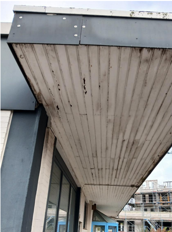
Abbildung 8: Einflugmöglichkeiten durch Holzüberdachung
