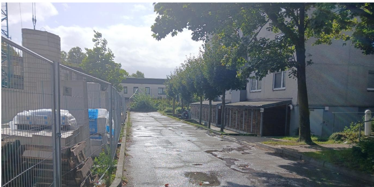
Abbildung 5: Blick von der Bertha-von Suttner-Straße Richtung Süden auf das Praxisgebäude
