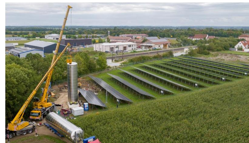
Luft-Wärmepumpe (750 kWth), Wärmespeicher (168 m<sup>3</sup>) und PV (700 kWp) in Mertingen, Bayern
